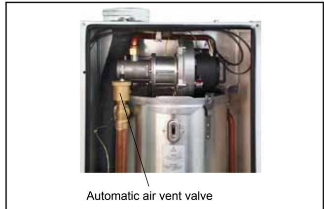
Fig.: Automatic air vent valve
